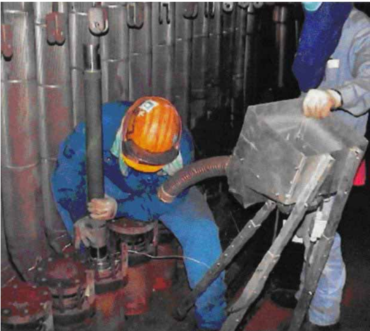
图 7 把Spiraload 装填管段放入转化管内
